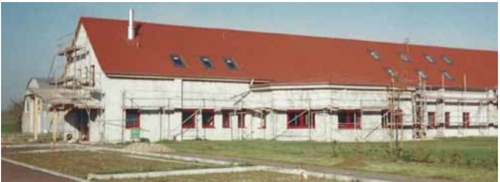
Gemeindezentrum mit Gerätehaus in der Bauphase (1999)
