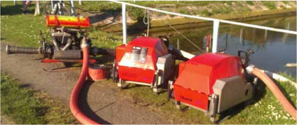
Alle Pumpen im Einsatz bei der Reinigung des Feuerlöschteiches 2015
