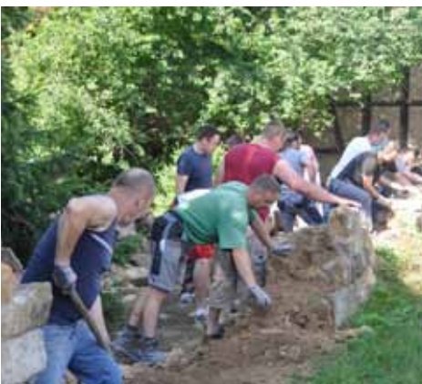
Sicherung der Mauer im Pfarrgarten (2013)
